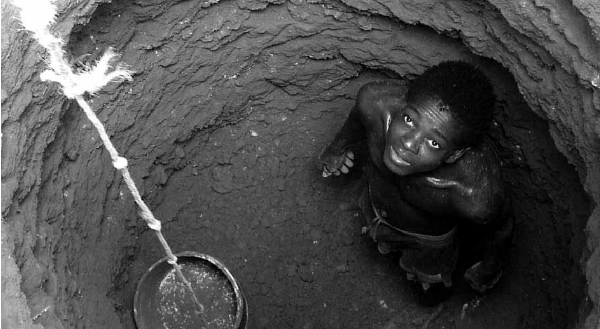
Construction d'une fosse à latrines en Haïti © Tdh / Antoine Delepière
